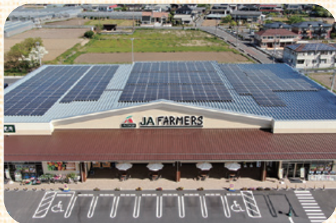
PPA事業でファーマーズ店舗の屋根に設置された太陽光発電設備
