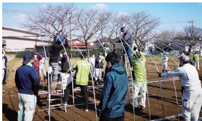
パイプハウス自力施工研修
