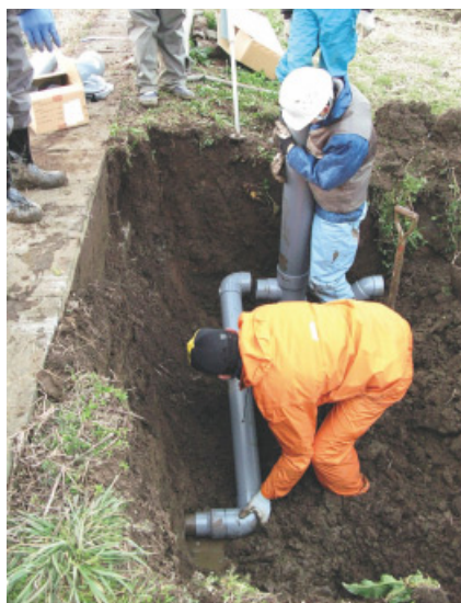
▲水位制御器の設置作業
