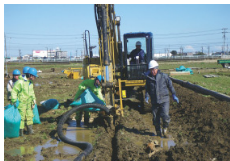
▲バックホーによる幹線パイプ埋設と もみながら投入の同時作業
