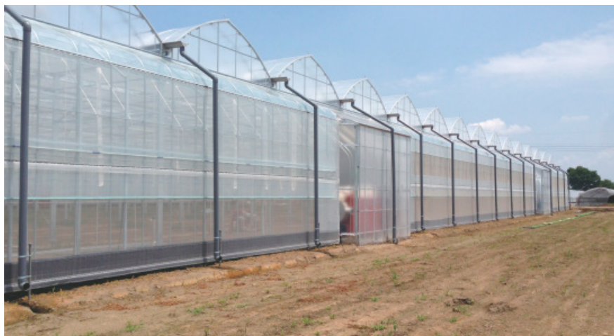
▲高さ5mの高軒高ハウス
