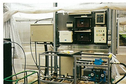
②液肥による追肥の施用(液肥混入装置)
