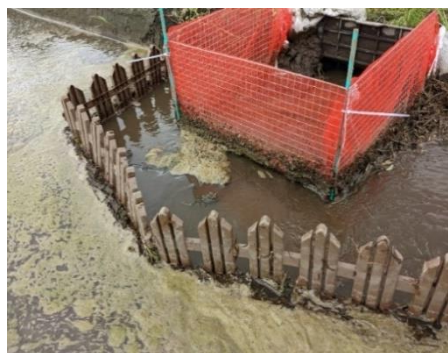
水尻口への防止柵の設置
