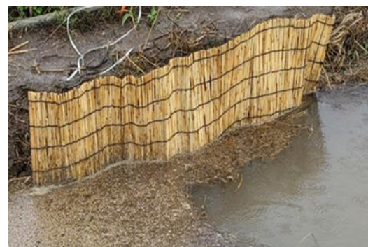
様々な資材を活用した防止策の設置
