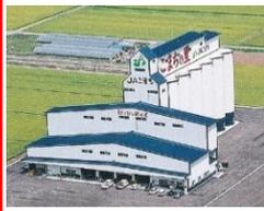
カントリーエレベーターとは・・・お米の乾燥機とサイロ (貯蔵タワー) をエレベーターでつないだ大型倉庫のこと。大型乾燥機ではもみをほどよく乾燥させ、温度や湿度を管理したサイロで貯蔵します。そして、もみすりをして玄米にし、袋に詰めて出荷します。
