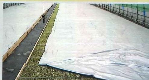
緑化始期：べた張り除去の様子
