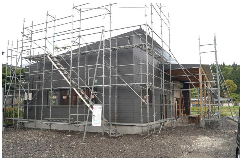
建設中の野菜集荷選別所（兼）事務所（5月11日）
