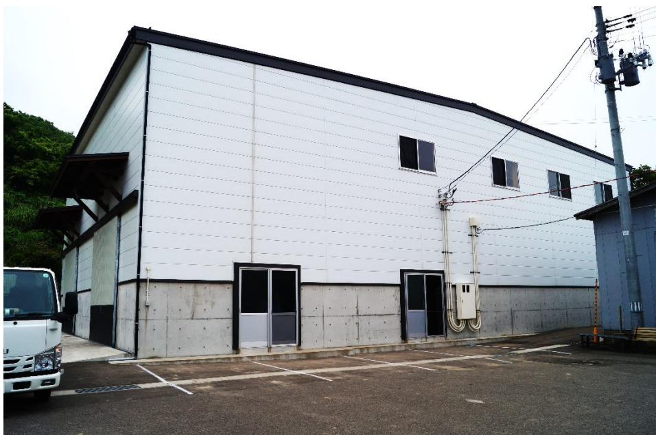
令和元年から稼働した新たなライスセンター
