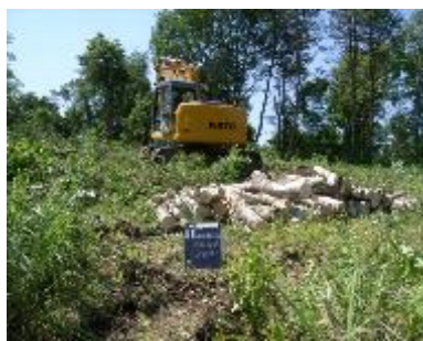
重機で整備中
