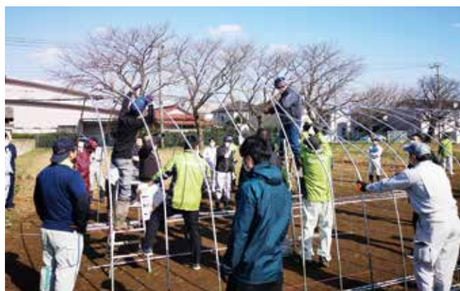
パイプハウス自力施工研修
