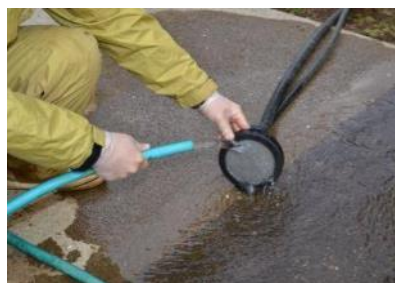
ストレーナーの洗浄 目詰まりがないか確認！
