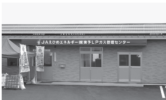
▲太陽光発電パネルを配した事務所
