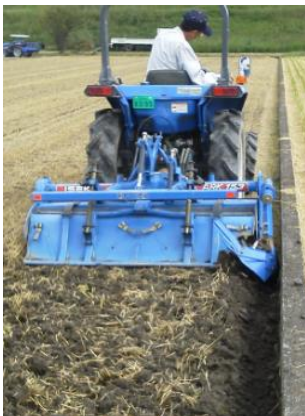
写真4 額縁明渠の施工
