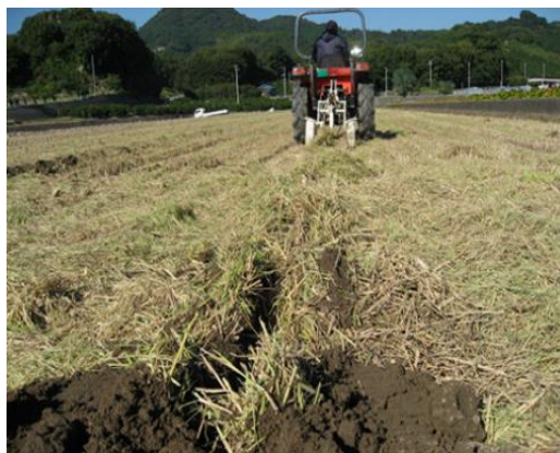
写真5 弾丸暗渠の施工
