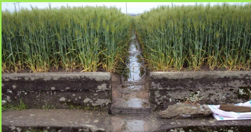
写真2 排水溝と導水路の接続
