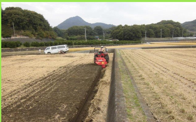
写真1 額縁明渠の施工
