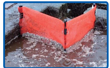
② 水尻へのネット設置
