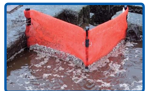
② 水尻へのネット設置
