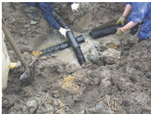
▲有孔管の接続作業
