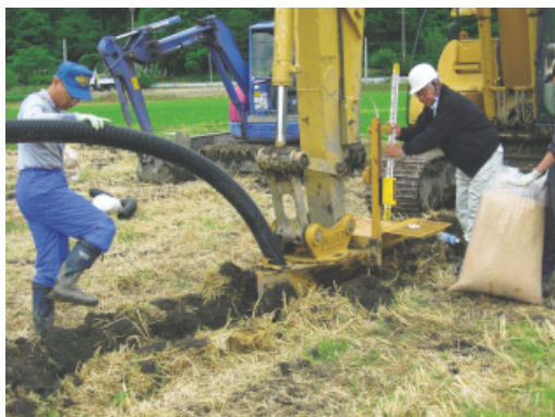
▲アーム式ベストドレーンによる有孔管敷設 (もみぐら同時投入)
