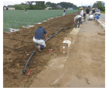
写真-4 かん水装置の設置
