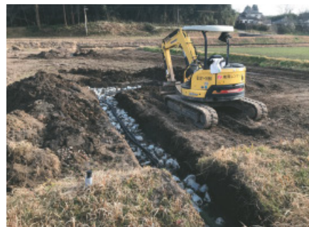
写真-2 湧水部の追加暗渠施工
