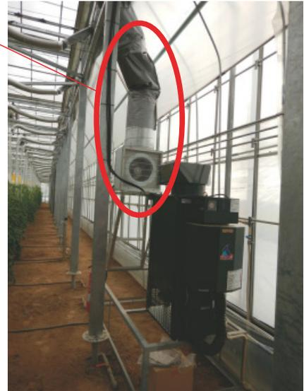
写真-1 トマト群落内に二酸化炭素ダクトを設置して送風ファンで送り込んでいる
