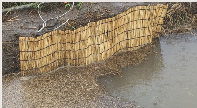
写真1 「すだれ」を用いた流出防止装置実証試験
