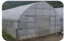
パイプハウス
