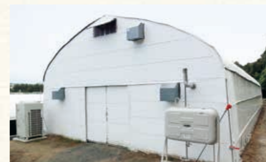
簡易空調ハウス
