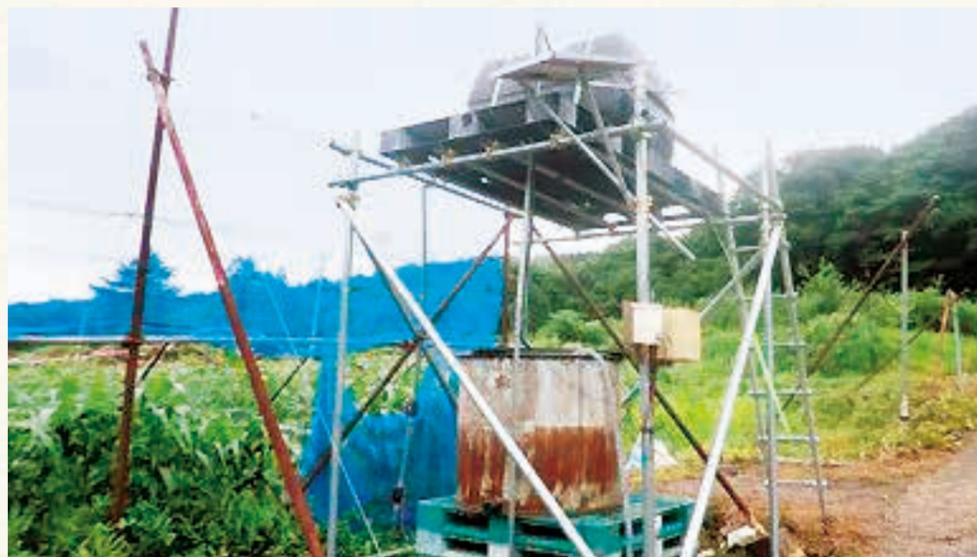
ソーラーパネル揚水落差式灌水システム
