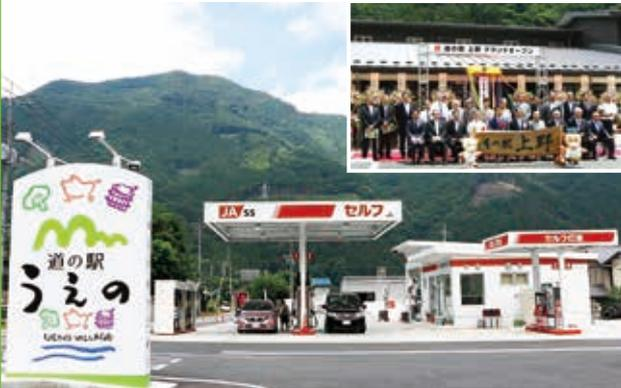
県内第1号の道の駅として平成6年に登録された「道の駅上野」は、施設の老朽化と求められる役割の多様化・高度化に対応するため、機能の充実と周辺施設を含めた再整備が進められていました。隣接する上野村給油所の再整備については、当県本部一級建築士事務所が設計監理を担当し、昨年9月に完成しました。災害時に備えた地域におけるエネルギー供給拠点として、停電時も発電機による給油が可能となっています。
