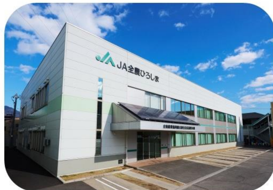
全農広島県本部 大町事務所
