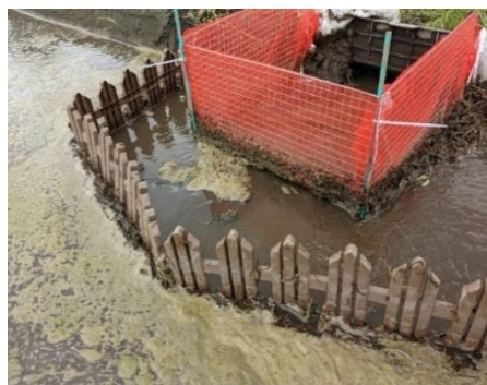
水尻口への防止柵の設置
