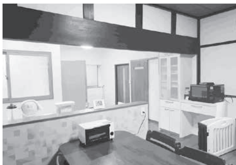
既存の梁を活かしたダイニング
