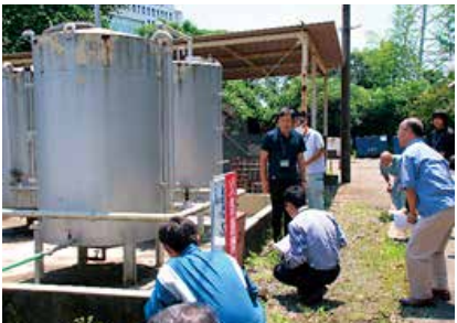
オイルタンクの点検ポイントを学ぶ参加者
