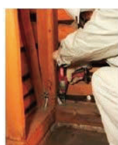
①柱を接合金物で梁や土台に固定。
