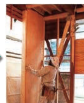
④断熱材を入れて、構造用合板を打付け。
