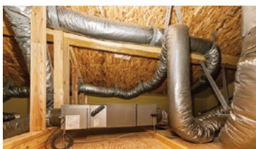
全館空調システム：温度調整・除湿等を行った空気を「搬送ファン」を通じて各部屋に送るシステム
