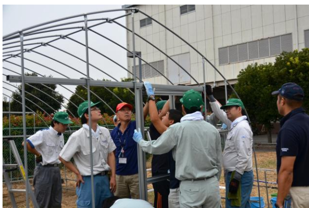
スライドドアの取り付け方を実習する参加者ら
