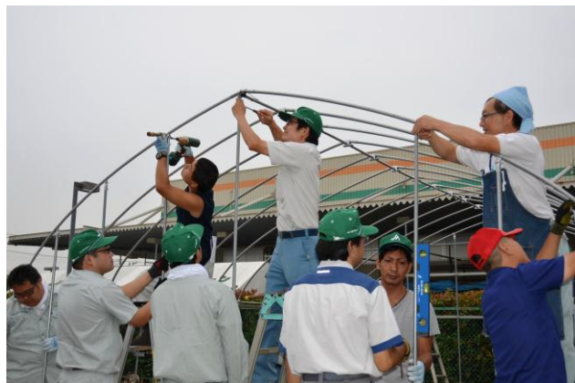
パイプハウスの建て方を参加者全員で実習した
