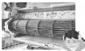
★エアコンクリーニング★
