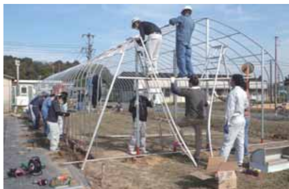
パイプハウス自力施工研修会（県農研敷地内）
