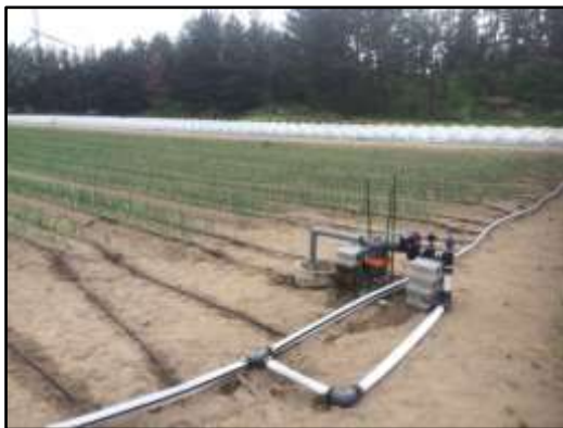
点滴灌水管装置の設置状況
