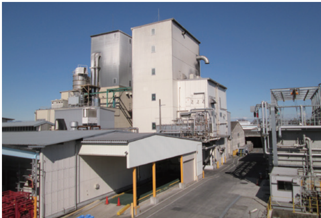
ドライヤー棟
