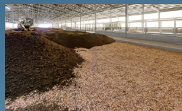
福島県で唯一のコンポストバーン。敷料の下にウッドチップを敷いて水分量を調節。さらにその下に通したパイプからエアーを送り込む
