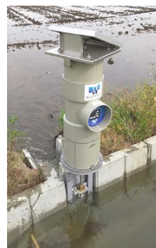
▲開水路の設置例
