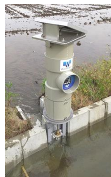
▲開水路の設置例
