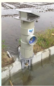
▲開水路の設置例
