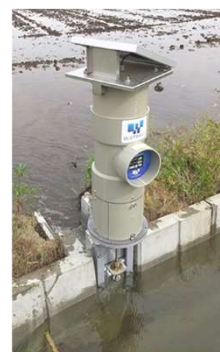
▲開水路の設置例
