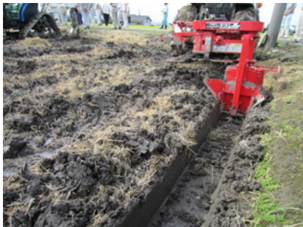
スクリーオーガーによる額縁排水溝の設置
