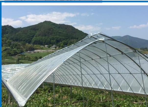
・ビニールを固定張りにしたままで、天井部分に換気口を設置することによって高温障害防止になります。
