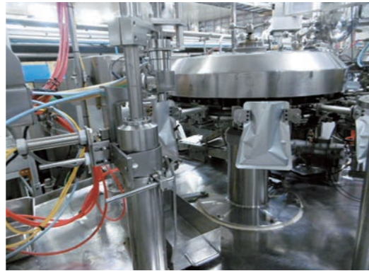
⑤充填工程
