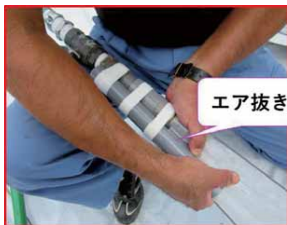
図7 注水作業とエア抜きパイプの利用 (図のホースは透明タイプ)
